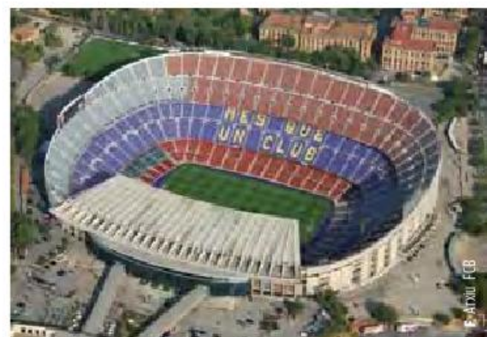
Vista aèria del Camp Nou.
